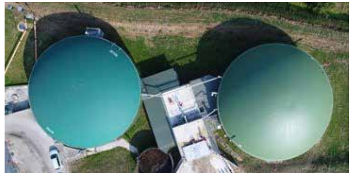
Biogasanlage in Bentzin (Landkreis Vorpommern-Greifswald). In der Anlage soll durch die Kombination von Ultraschall- und Plasmabehandlung der Aufschluss von verarbeiteten Biomassesubstraten, und damit letztendlich der Biogasertrag, gesteigert werden.
